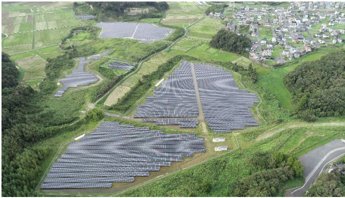
成田神崎プロジェクト 神崎町植房地区
