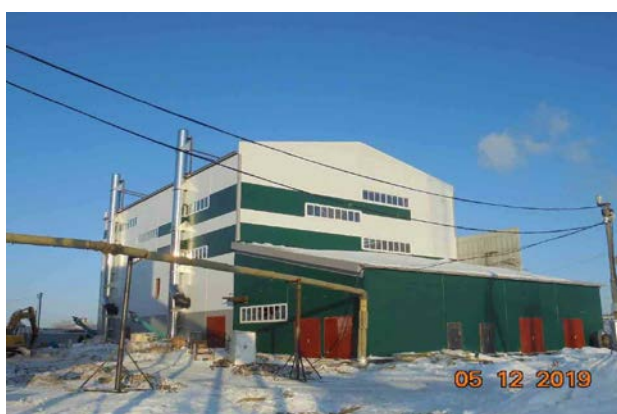
ボイラー工場の建設工事
