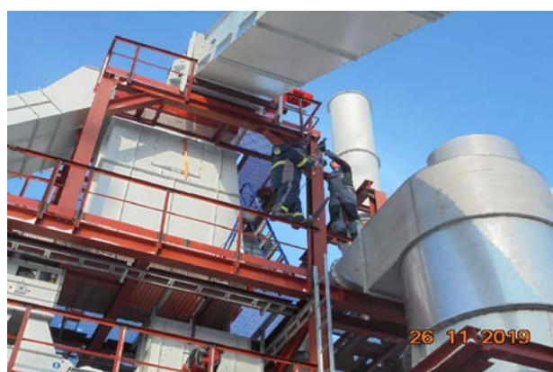
設備の建設工事 (ハンマーミル)
