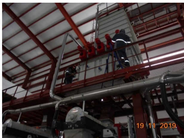
機器の設置工事（主要生産設備）
